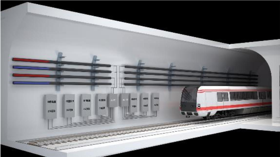
漏缆交叉极化 4T4R 方案提升地铁隧道 5G 性能
